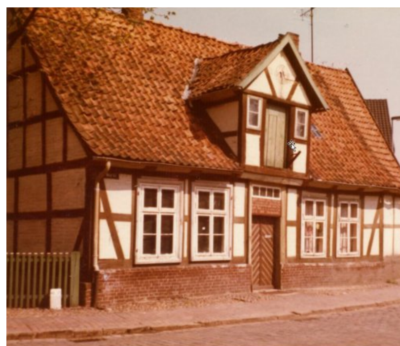
Die Alte Wache kurz bevor sie im Mai 1973 abgerissen wurde. Links vom Eingang befand sich zur Straße hin das Amtszimmer des Bürgerdieners, dahinter das Büro des Bürgermeisters. Rechts vom Eingang waren die Wohnräume des Bürgerdieners.
